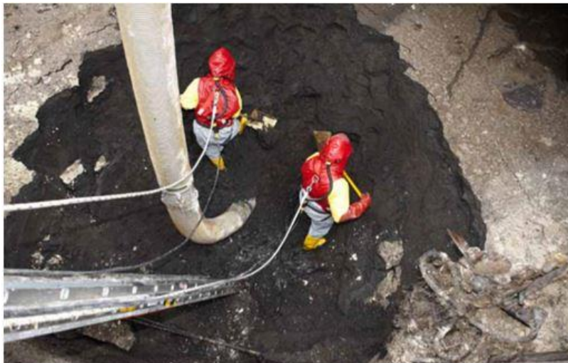
Slika 6. Mjere sigurnosti kod održavanja digestora (Bontempo i sur., 2016).
