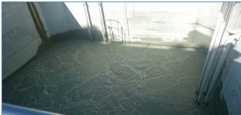
Slika.5. - Egalizacijski bazen u punionici Jamničke kiselice, Pisarovina. (izvor: Jamnica, vlastita fotografija)
