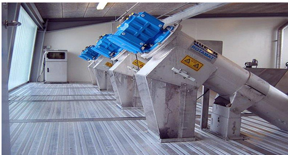
Slika 6. Fine rešetke HUBER ROTAMAT® Fine Screen Ro 1 kao polifunkcionalne jedinice u procesu obrade otpadne vode – izdvajanje, transport, pranje i sabijanje materijala (Anonymous 3, 2020)
