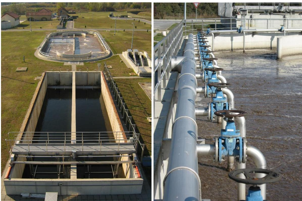
**Slika 7.** a) Sekundarna obrada s aeracijskim bazenom (gore) i sekundarnim taložnikom (dolje),
