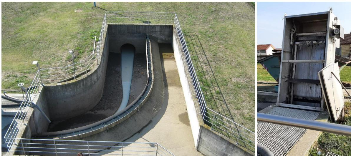
**Slika 5.** a) Preljevni kanal, b) automatska gruba rešetka (Anonymous, 2021)
