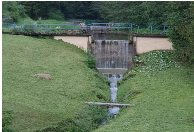
Slika 2. Delnički potok kao prirodni recipijent obrađenih otpadnih voda (vlastita fotografija)
