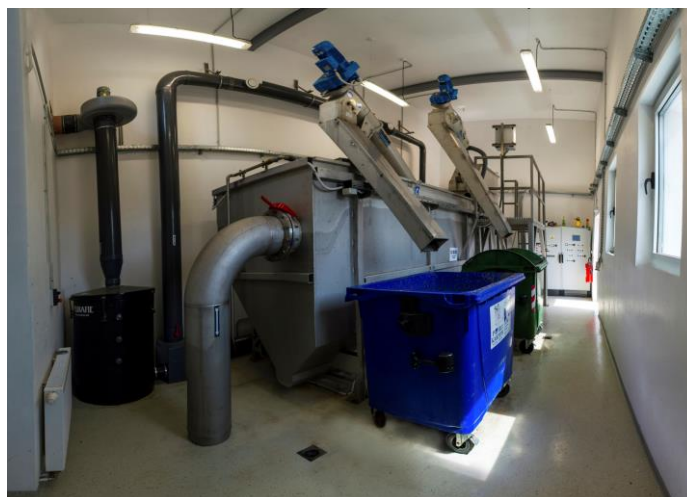
Slika 5. Kompaktna stanica za mehaničku obradu (vlastita fotografija)
