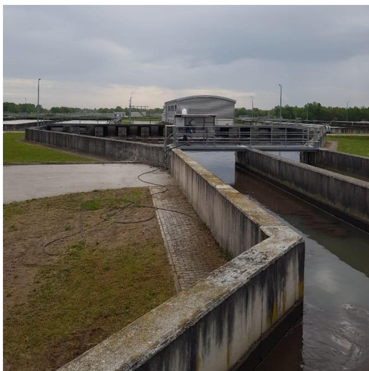
Slika 8. Kanal nakon primarnog taložnika iz kojeg su uzimani uzorci otpadne vode
