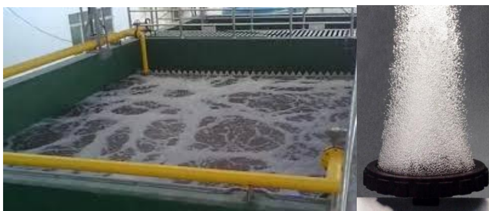
Slika 1. Prikaz konvencionalne aeracije otpadne vode i difuzora za fine mjehuriće zraka (preuzeto s https://www.blueingreen.com , preuzeto: rujan, 2018.)
