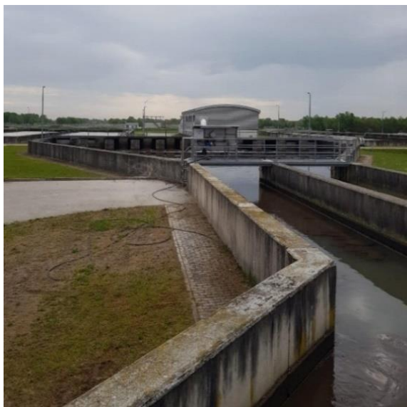
Slika 17. Kanal nakon primarne taložnice iz kojeg su uzimani uzorci otpadne vode (vlastita fotografija)
