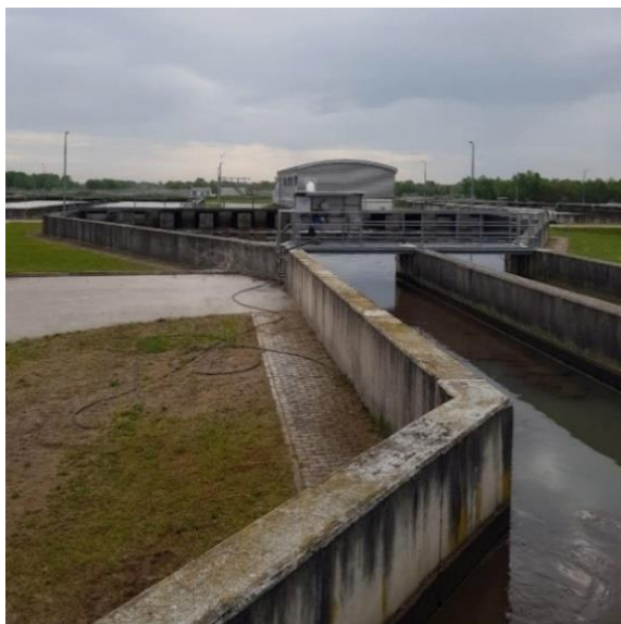
Slika 17. Kanal nakon primarne taložnice iz kojeg su uzimani uzorci otpadne vode (vlastita fotografija)
