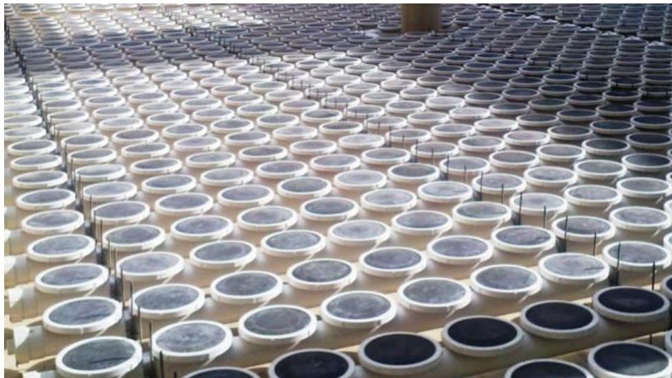
Slika 1. Disk difuzori s gumenim membranama (Anonimus 1, 2012)
