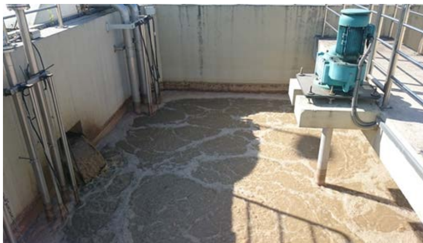
Slika.7. – Aeracijski bazen u punionici Jamničke kiseline, Pisarovina. (izvor: Jamnica, vlastita fotografija)
