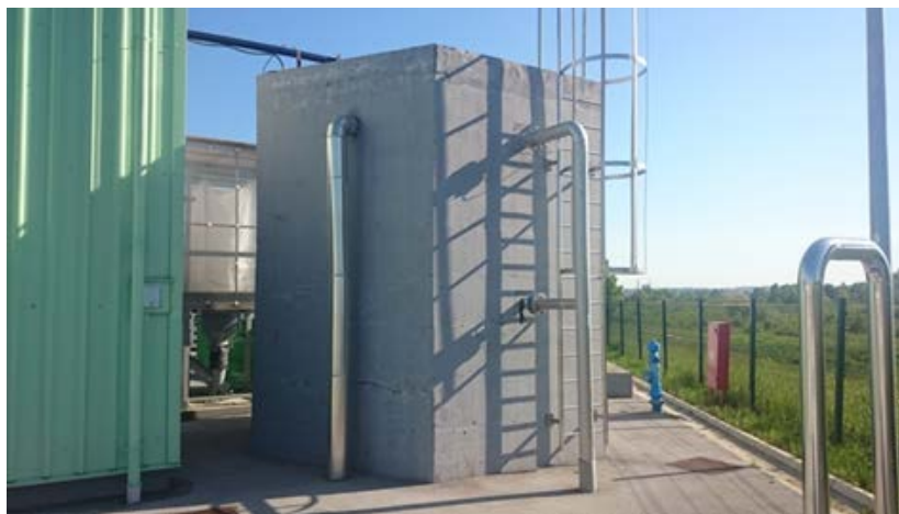
Slika.8.- Zasebni spremnik mulja u punionici Jamničke kiselice, Pisarovina. (izvor: Jamnica, vlastita fotografija)
