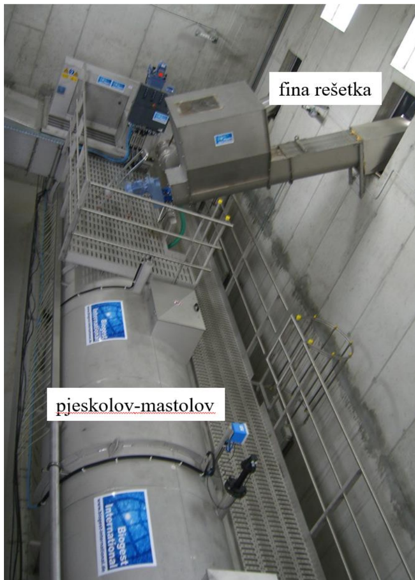
Slika 6. Kompaktni mehanički tretman influenta (fina rešetka, pjeskolov i mastolov)
