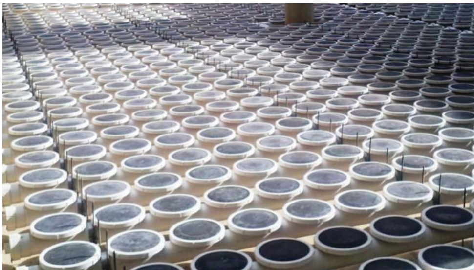
Slika 1. Disk difuzori s gumenim membranama (Anonimus 1, 2012)
