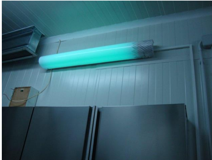
Slika 4. UV lampa u prostoru za pakiranje u modificiranu atmosferu.
