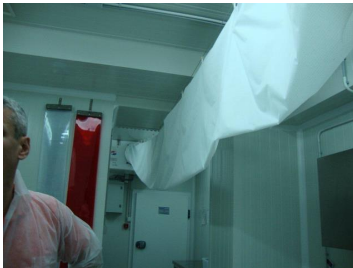
Slika5. Ventilacija u prostoru za pakiranje u modificiranu atmosferu.
