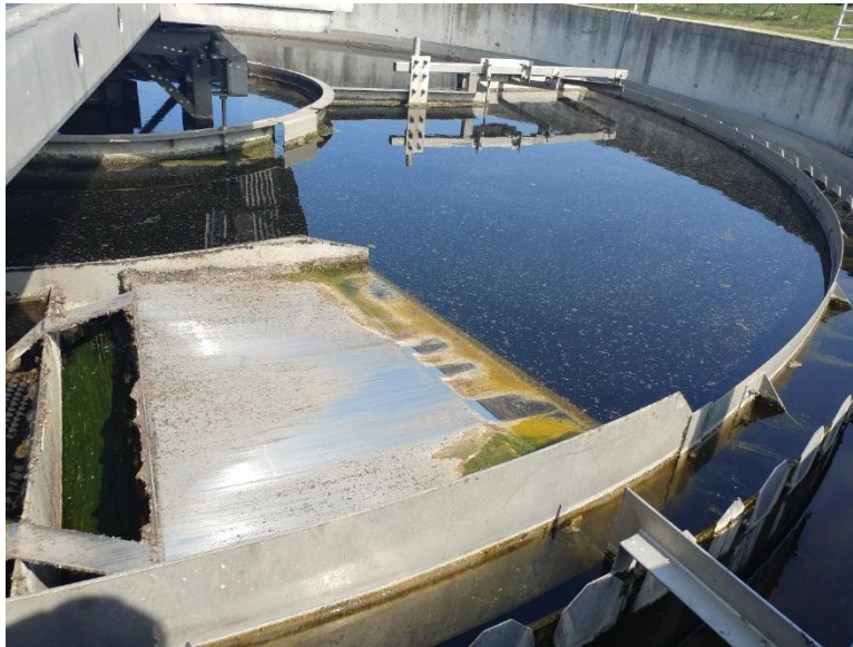
Slika 12. Sekundarni taložnik (Anonymous, 2020).
