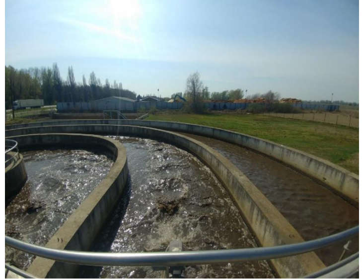
Slika 11. Kanali bioaeracijskog bazena (Anonymous, 2020).
