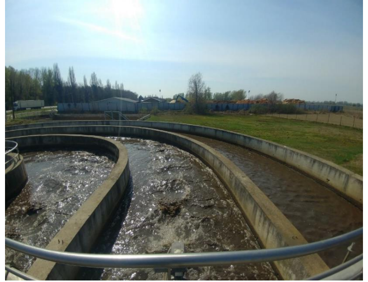
Slika 11. Kanali bioaeracijskog bazena (Anonymus, 2020).
