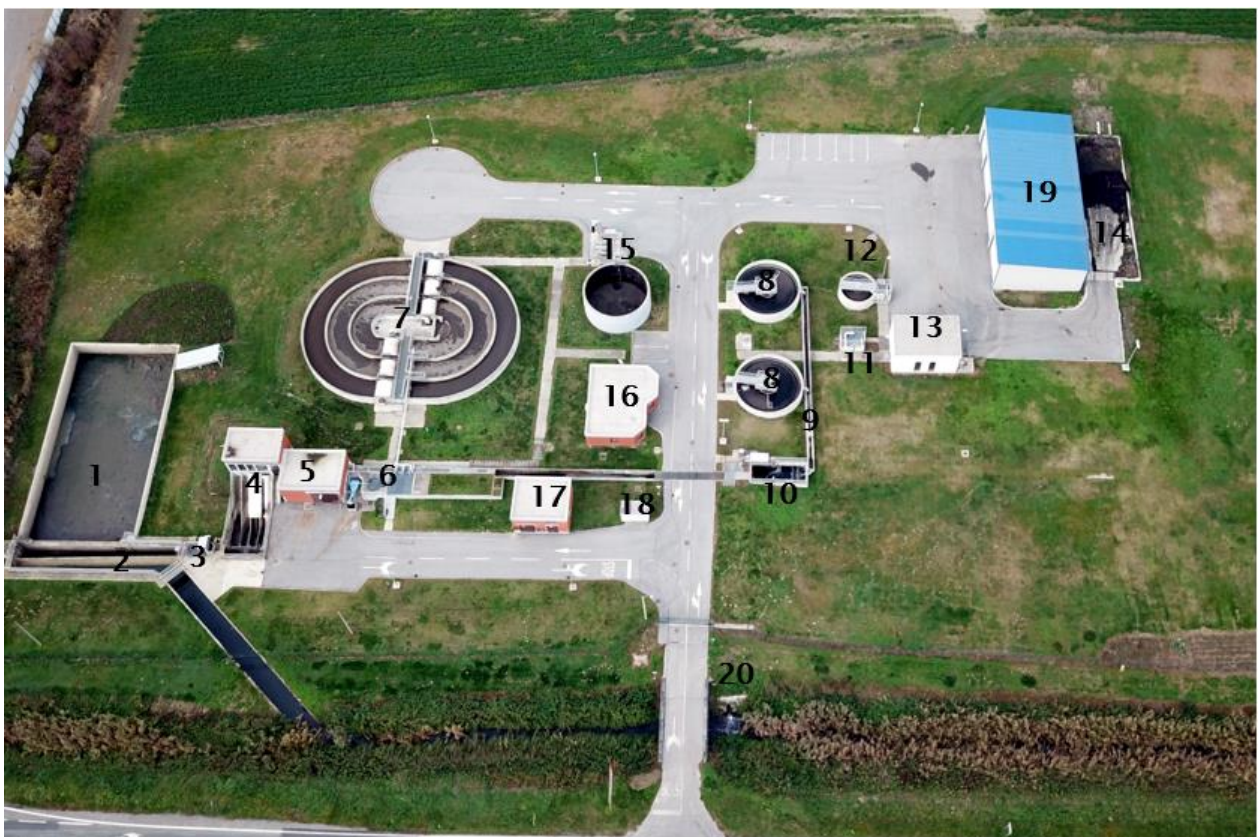
Slika 6. Uređaj za pročišćavanje otpadnih voda grada Donjeg Miholjca (Anonymous, 2020).
