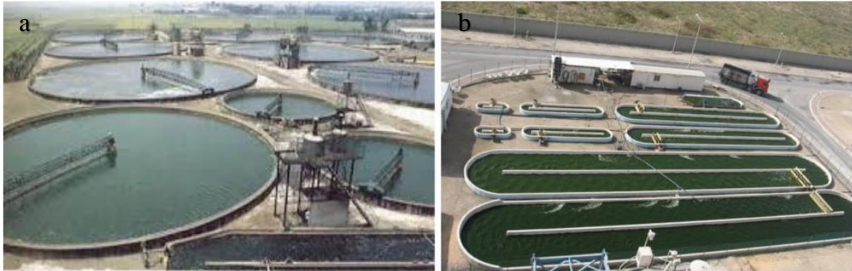
Slika 2. Prikaz otvorenih bioreaktorskih sustava za uzgoj mikroalgi (a) kružni bazeni (b) otvoreni bazeni s recirkulacijom podloge (El-Baz i Baky, 2018).
