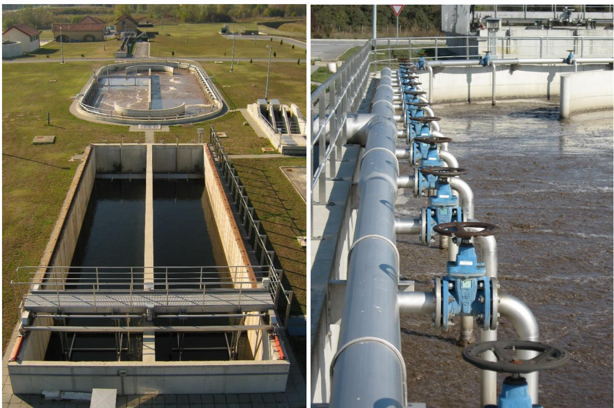
Slika 7. a) Sekundarna obrada s aeracijskim bazenom (gore) i sekundarnim taložnikom (dolje), b) ML (Anonymous, 2021)
