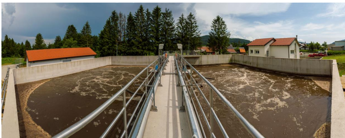
Slika 7. SBR bazeni (vlastita fotografija)
